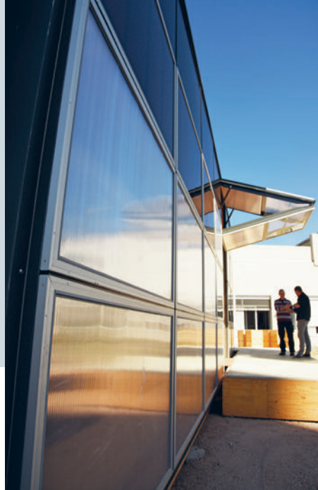
Die Flügel heben und falten sich, angetrieben durch eine Gasdruckfeder. Aus Gewichtsgründen musste im Bereich der normalen Verglasung auf Polycarbonat-Platten ausgewichen werden. Les battants se soulèvent et se replient, entraînés par un vérin à gaz. Pour des raisons de poids, les concepteurs ont dû se rabattre sur des panneaux en polycarbonate dans la zone du vitrage normal.
