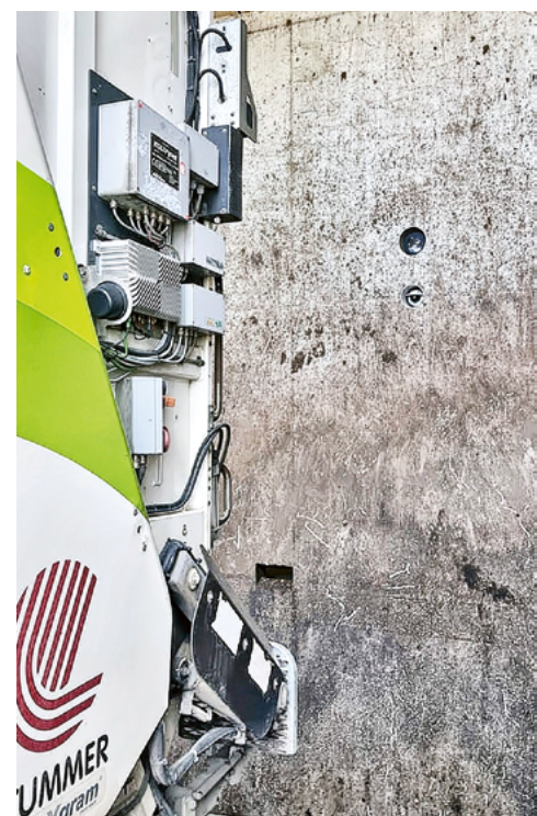
Installation biowaste: camion de collecte et caméra dans le mur au lieu de traitement
